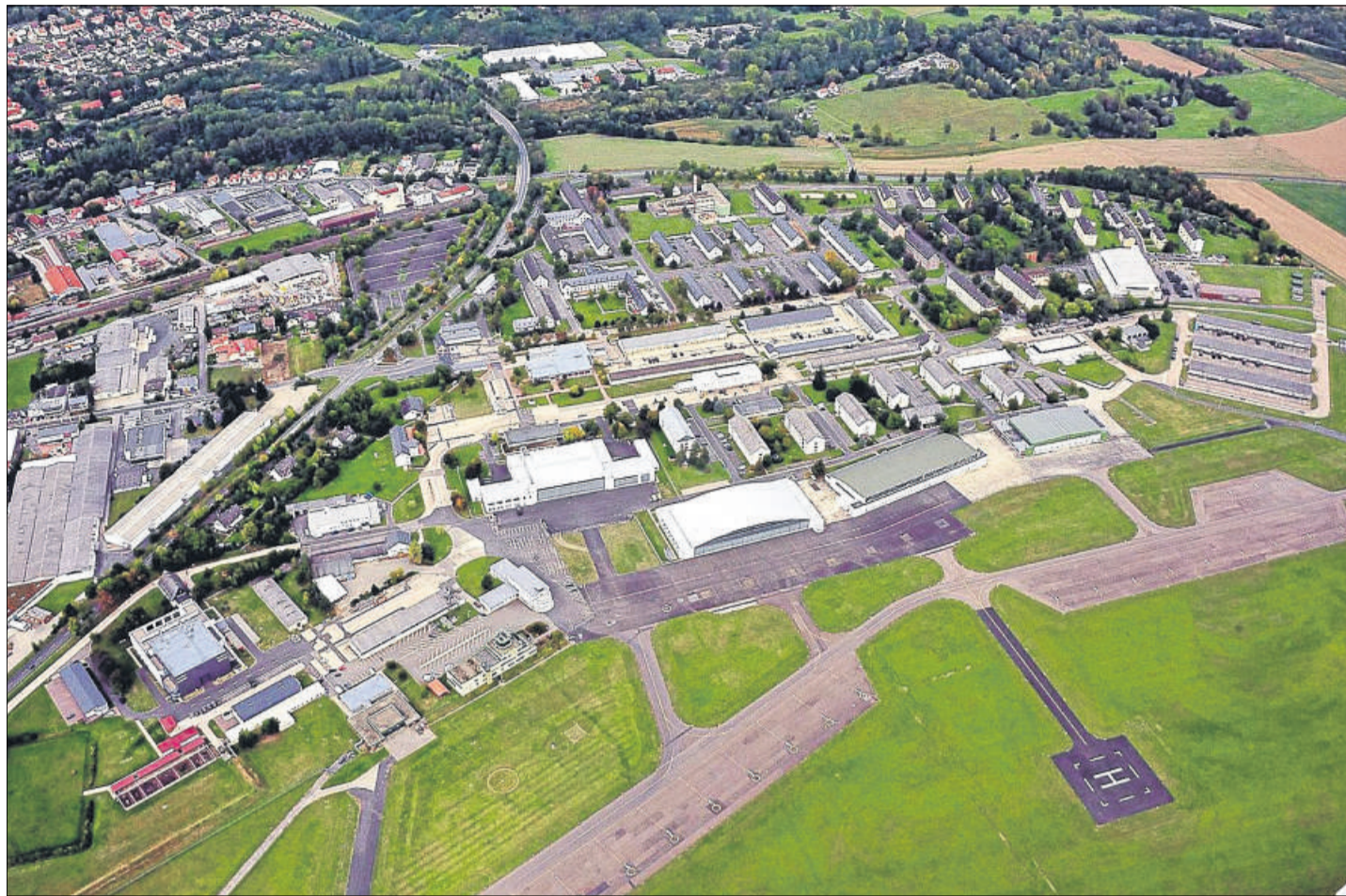
Millionen für die Bundeswehr: In die Fritzlarer Georg-Friedrich-Kaserne wurden für die neuen Kampfhubschrauber geschätzte 140 Millionen Euro investiert, nun wird weiteres Geld für die Sanierung nötig sein. Foto: Zerhau
